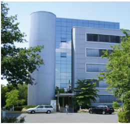
Das VR Payment Gebäude in Ettlingen
